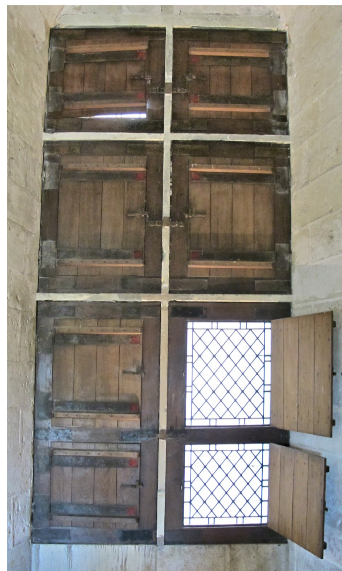
Fig. 7 - Châteaudun, château, aile Dunois. Les croisées restituées par l'architecte Jean Trouvelot à partir de 1938 selon le modèle d'origine.
