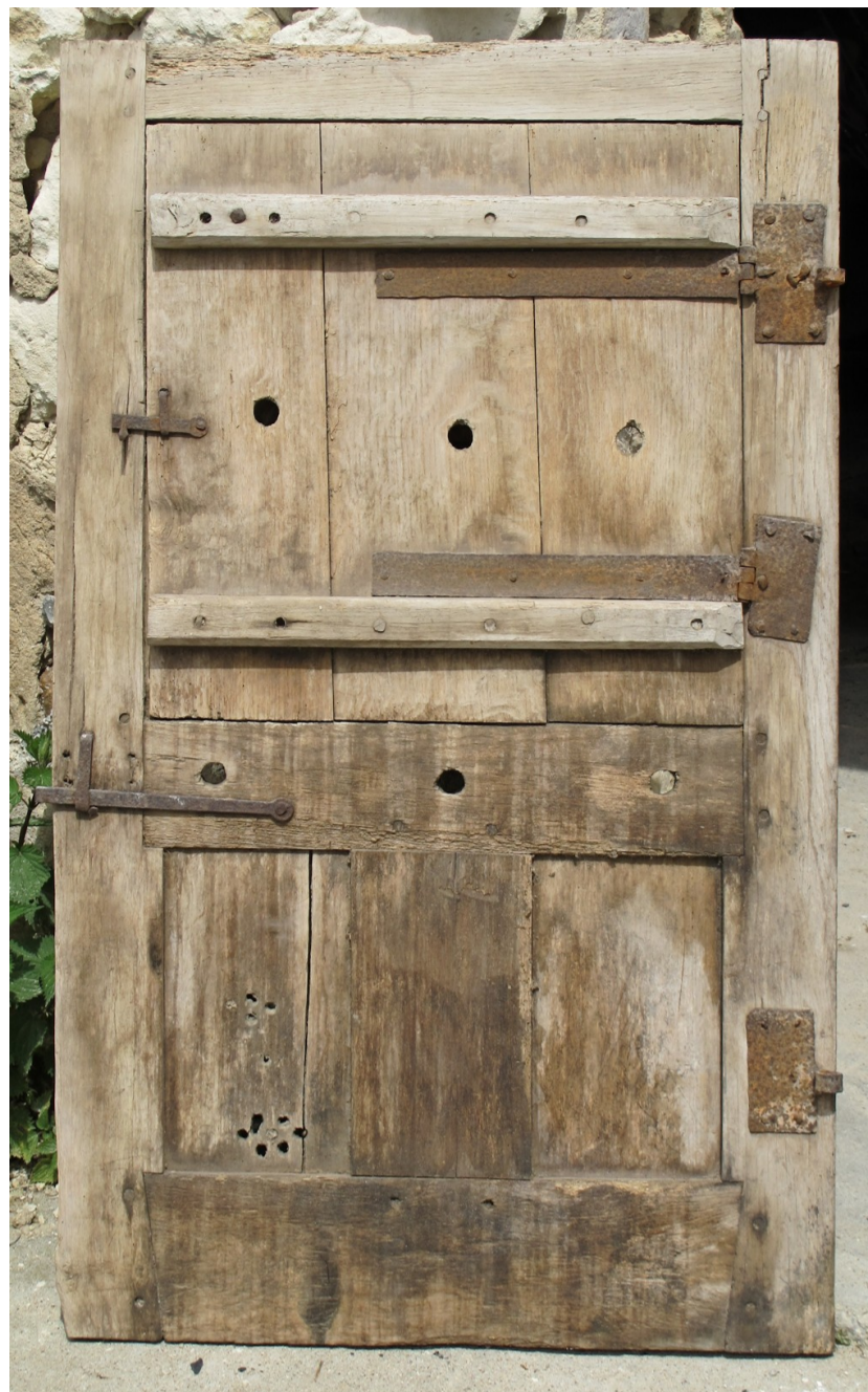
Fig. 14 - Bocé (Maine-et-Loire), manoir de Valette Volet de planches fermant le compartiment vitré du vantail consolidé par un soubassement à panneaux
