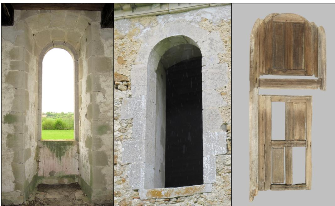
à cette demi-croisée de conserver en totalité ses éléments cintrés (fig. 12). On notera que la sous-face de la traverse haute du volet demeure rectiligne à l'instar des exemples précédents pour simplifier sa fabrication (fig. 12).
